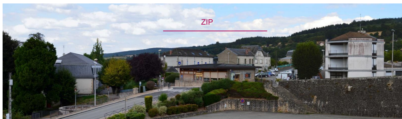
Photographie 82 : Vue en direction de la ZIP depuis l'esplanade du château, à proximité de la tour Lastic
